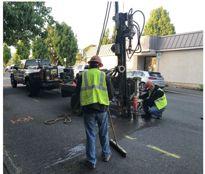
Equipo de construcción que realiza trabajo de campo en el área del proyecto. Al igual que con el trabajo de campo, la construcción utilizará herramientas tales como escobillas para capturar y eliminar la tierra y los desperdicios sueltos producto de las actividades de construcción, las máquinas y los vehículos durante el trabajo y después de este.
